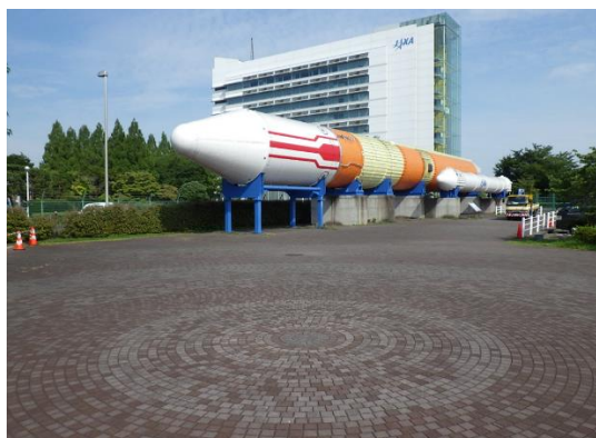
図-1 ロケット広場の改修前の様子
