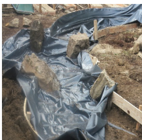
写真-6 沢流れ施工 ①
