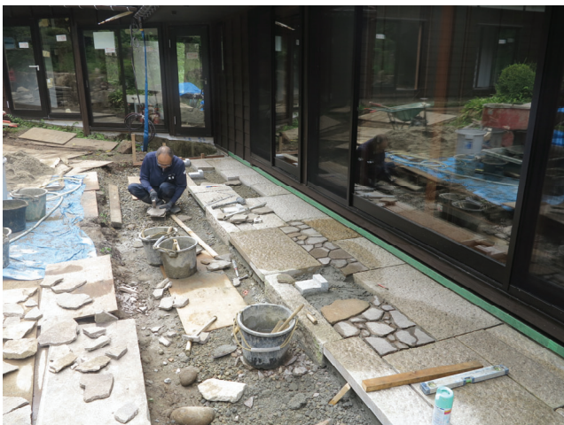
写真-5 犬走り延べ段施工
