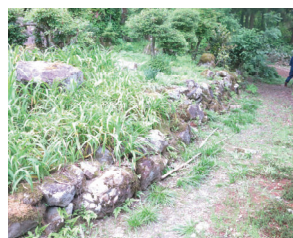
写真-4 着手前（石積み）
