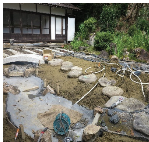
写真-7 沢流れ施工 ②
