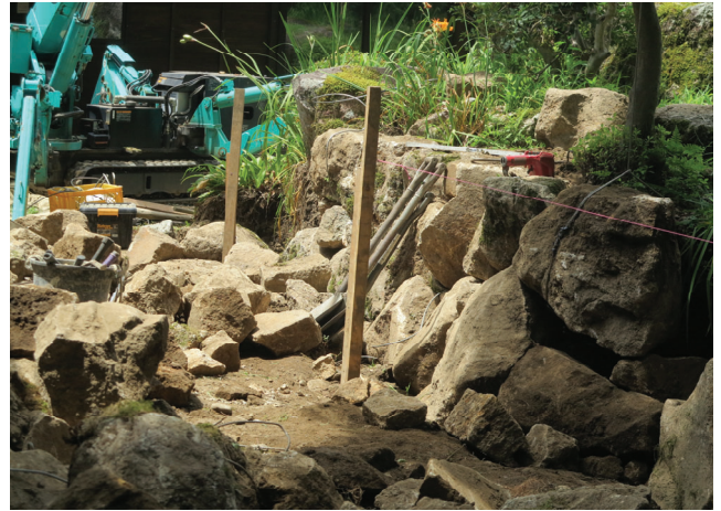
写真-8 石積み施工
