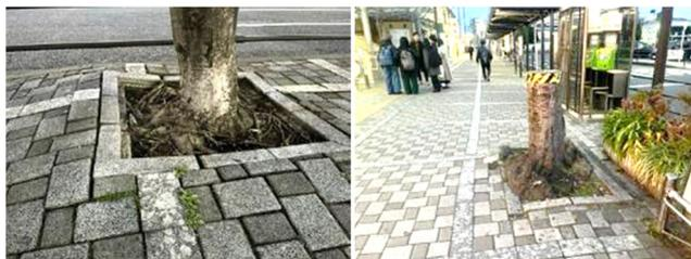
図-1 根上り(左)と根系が肥大化し除伐される樹木(右)
