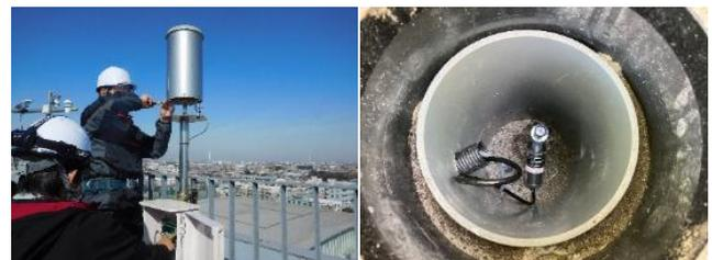
図-10 屋上に雨量計取付(左)と観測孔に水位計設置(右)
