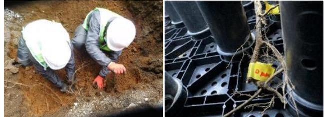
図-7 根に注意して慎重に行う掘削(左)と貯留材への誘導(右)
