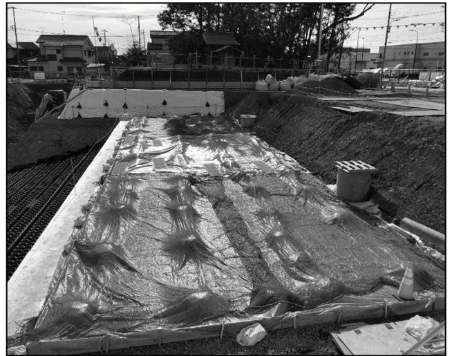
図-2 ブルーシート敷設状況
