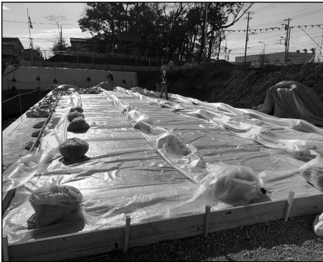
図-1 気泡緩衝材と剪定枝チップ設置状況
