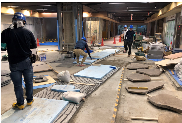
写真-3 石工事の作業状況
