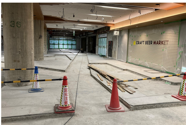
写真-2 既設舗装の撤去後（凹みは石工事範囲）
