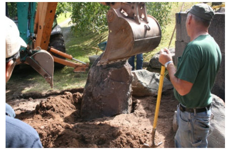
写真-1 役石据え付けの現場
