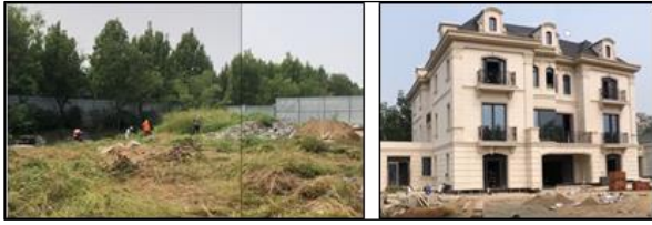
図-2 対象地の写真（庭の一部と住宅の一部）
