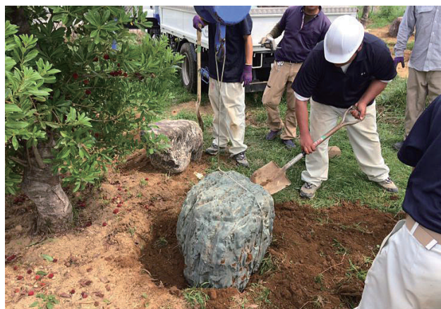
写真-1 石の据え付け実習
