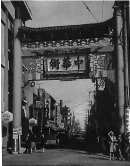
写真-2 牌樓門(1955年建設) 18)
