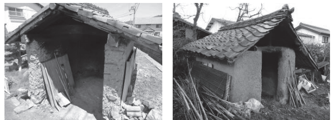
写真-1 現存する灰小屋(灰小屋として利用)
