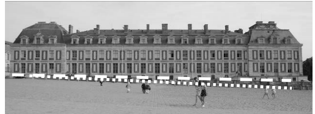
写真-7 閣僚翼棟 (北) と中庭
