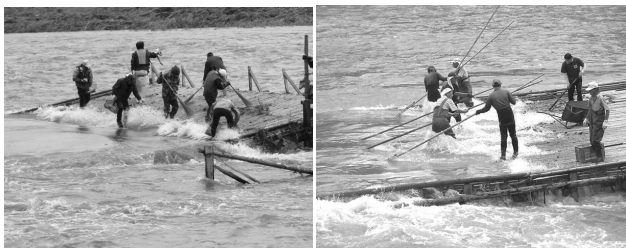
図一11 増水時には土砂除去の継続が求められる保守管理作業
