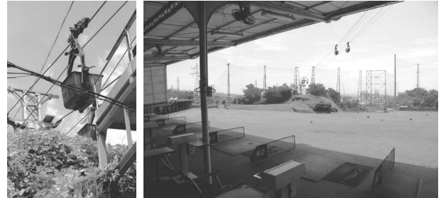
写真-4 日立セメント架空索道とゴルフ場
