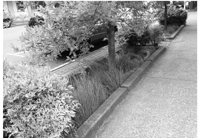
写真-1 グリーンストリート 雨水プランター型 (著者撮影)
