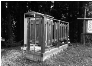
図-4 簡易トイレの設置
