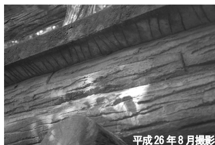
写真-3 有栖川宮公園に遺存する松村重の擬木擬石表現（左：擬木に施された枝の切口、中：橋桁に付された相決りによる継手、右：甌穴状に造作した擬石）
