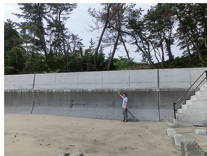
写真-6 大島内の田の尻海岸の防潮堤 ここはT.P.4mの防潮堤が元々あり、原形復旧でコンクリートの白い部分が追加された。70~80cmの地盤沈下があるという理由。また農地海岸であり、農地を守るための防潮堤であるが、背後には農地も人家もない。反対する住民もいないため、早期に工事は完了した (2014年7月撮影)。
