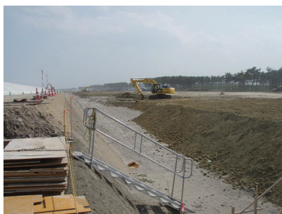
写真-2 進む防災工事
