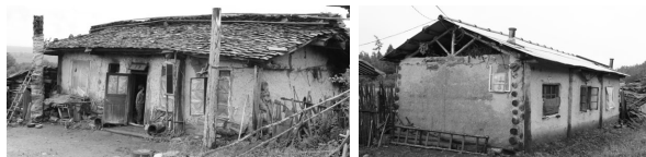
写真-1 錦江村の旧民家(左)と新民家(右)
