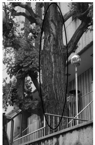
写真-7 (樹木番号 21) 爆心地側に亀裂が見られる イチヨウ
