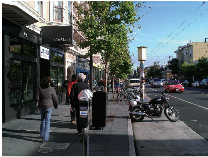
歩道拡幅と街路樹の整備を主とした簡潔な街路改修
