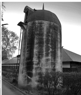
写真-5 コンクリートサイロ
