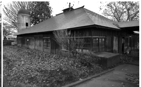
写真-3 旧五号牛舎東棟
