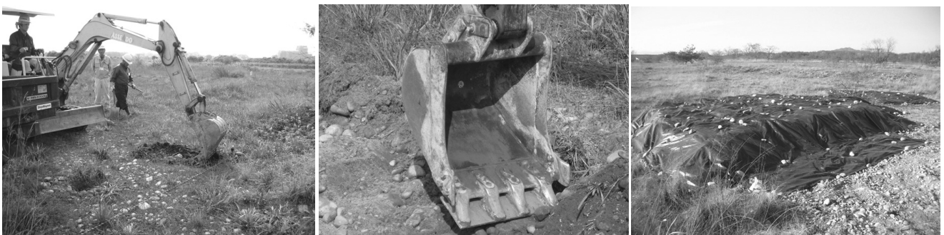
図-1 表土はぎとりの実施状況 (左: 施工開始時の状況, 中央: 刃先に鉄板を溶接したバケット, 右: はぎとった表土の堆積状況)
