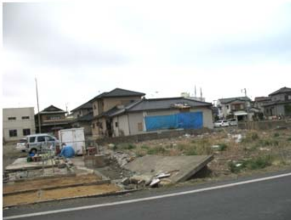
倒れたままのブロック塀
