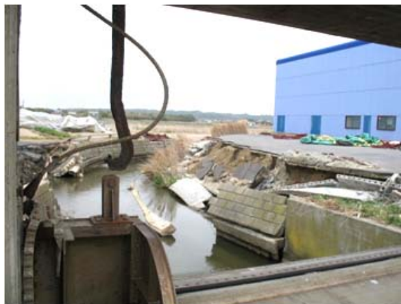
崩落したコン クリート護岸
