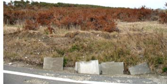
海岸防災林 浸水による 塩害
