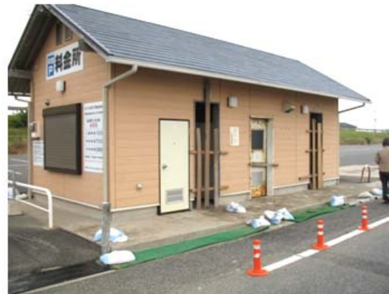
駐車場内 のトイレ 使用禁止
