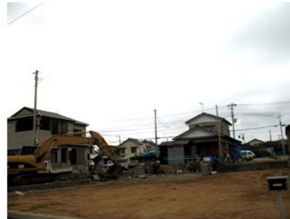
撤去中の被災住宅
