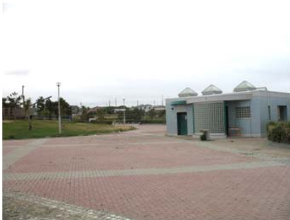
土砂が撤去 された園路
