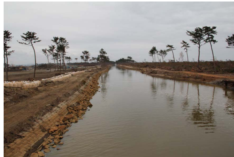
貞山堀の護岸崩壊と海岸林：海岸から約400m
