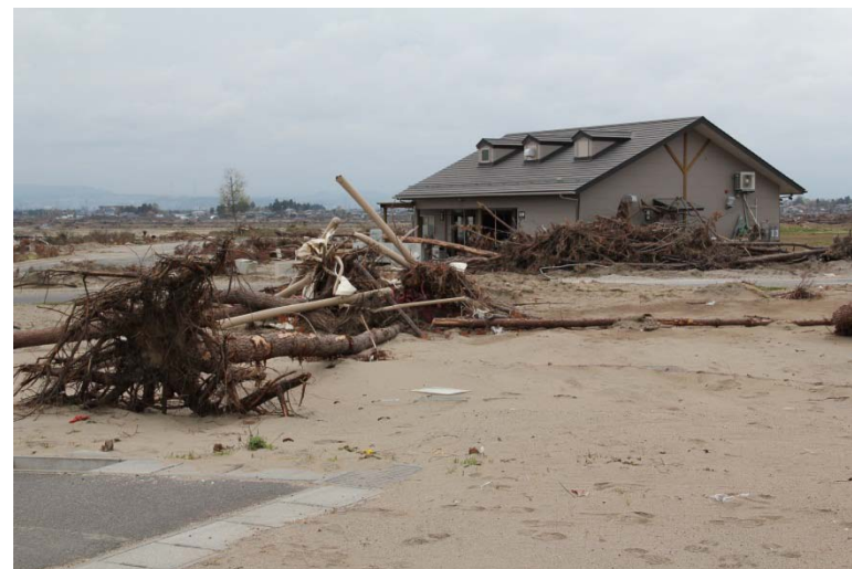
管理センター：海岸から約800m
