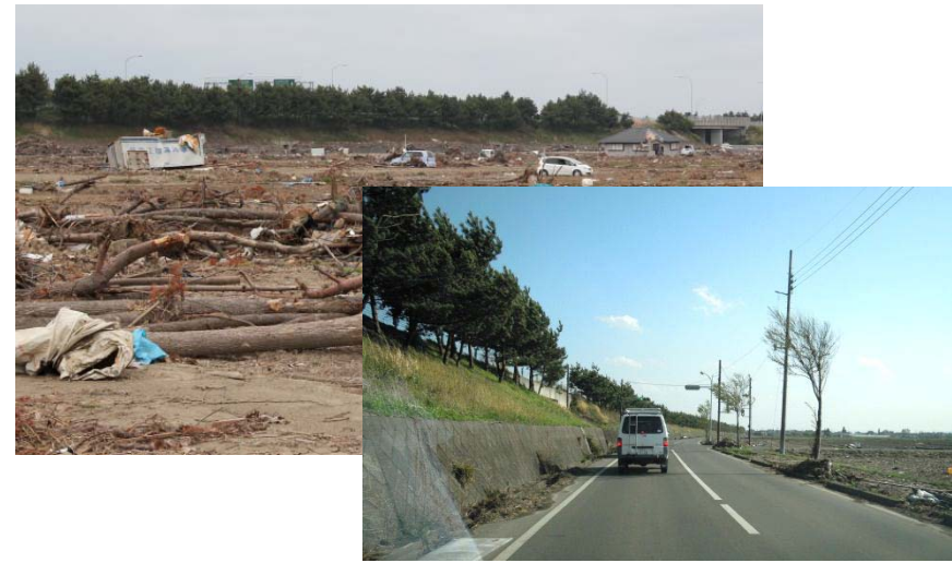
東部自動車道の土盛(浸水止め、避難地)：海岸から約3km
