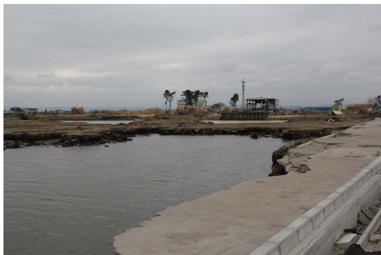
護岸消失と浸水による新池：海岸から約400m
