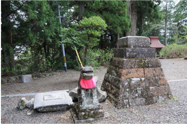
熊野本宮の被害
