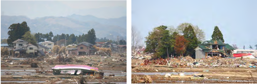
写真 -1・2 屋敷林 被害状況
