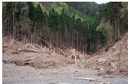
写真3: 柵内浜(佐賀部) 植林地の損壊
