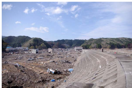
写真 5: 田老市街地 2重の堤防の内側
