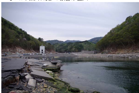
写真 8: 里地区 重茂港の被災
