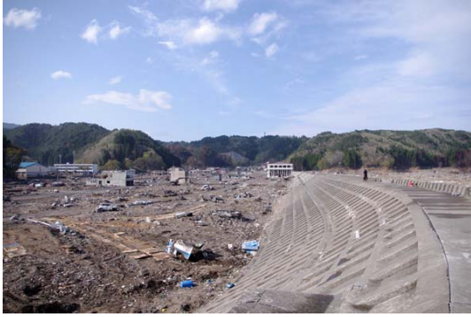
写真 4: 田老市街地 2重の堤防の内側
