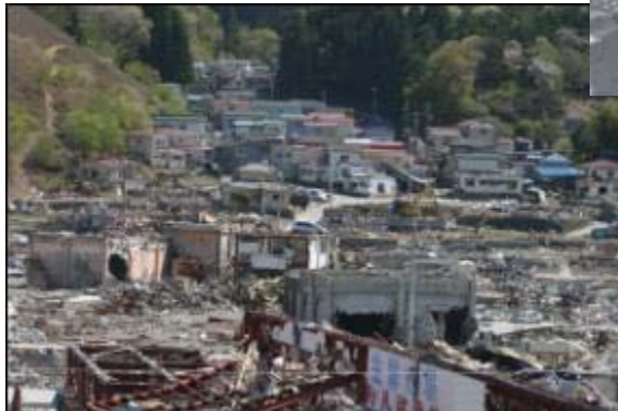
谷筋をかけたのぼる津波被害
