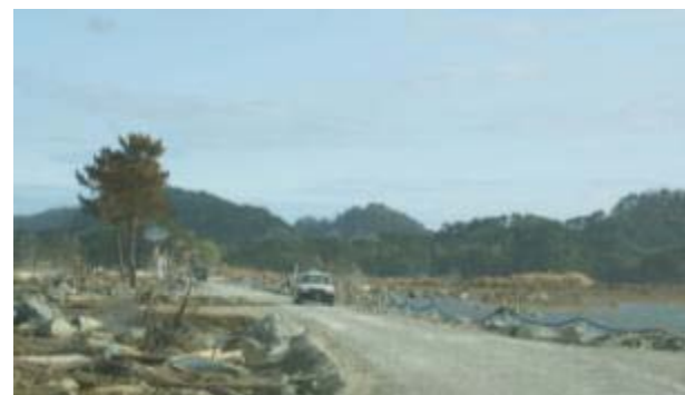
橋の流出など交通網が大きな被害を受けている
