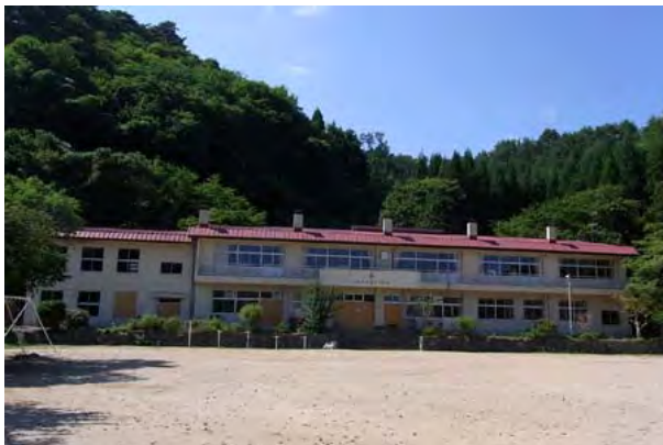
鵜磯:集落の最奥部にある鵜磯小学校の1階部分まで被災。小学校(標高約20m)からは海を見ることができる。(2011.8.27 撮影)
