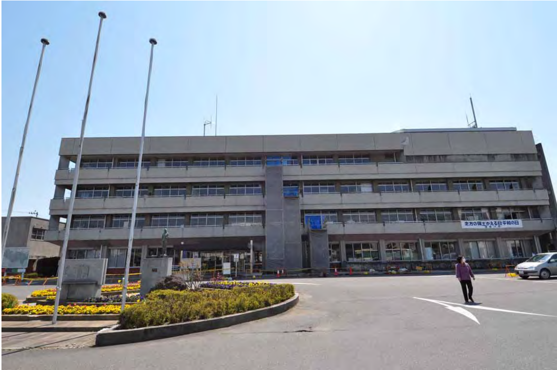
7 被災して使用不可能になった須賀川市庁舎
