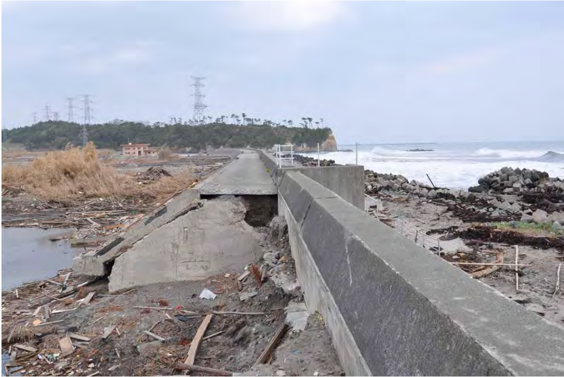
2 破壊された防潮堤、奥が東北電力グリーンパーク
