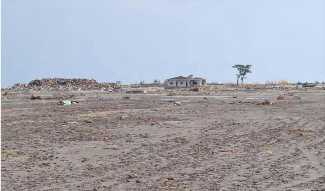
6 倒壊した建物と流木の瓦礫の山
