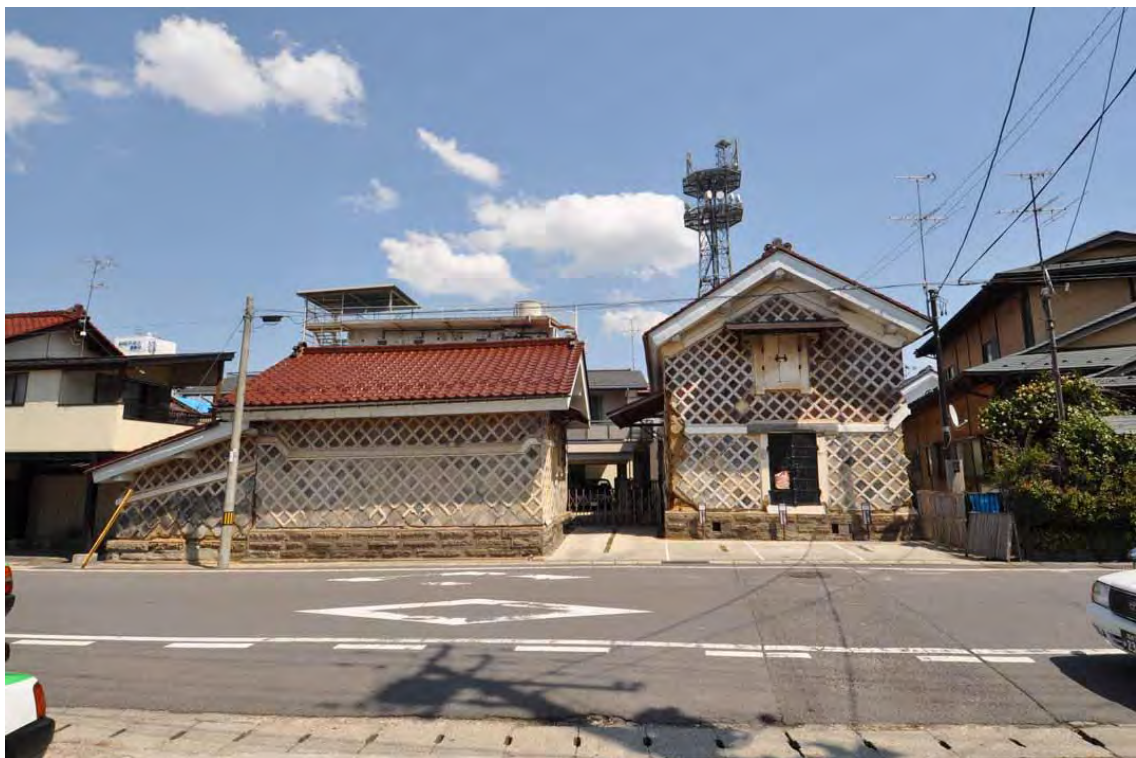
8 市役所周辺の被災した歴史的建築物
