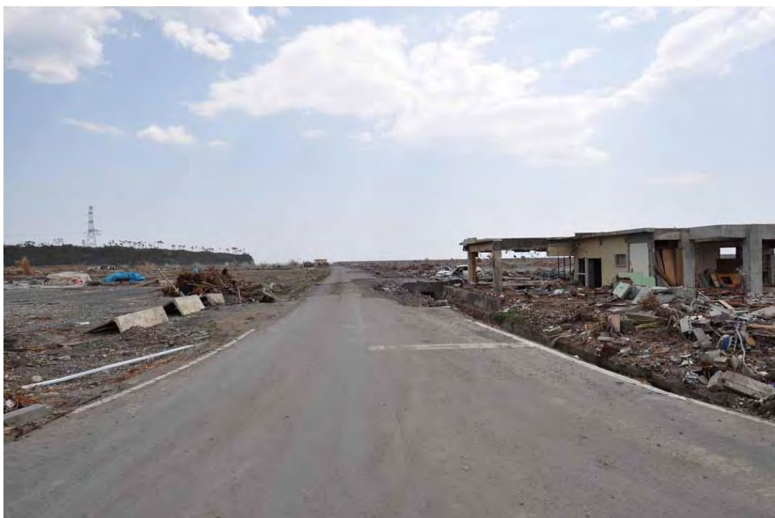
1 全建物が流失・全壊。左高台の緑は東北電力グリーンパーク
