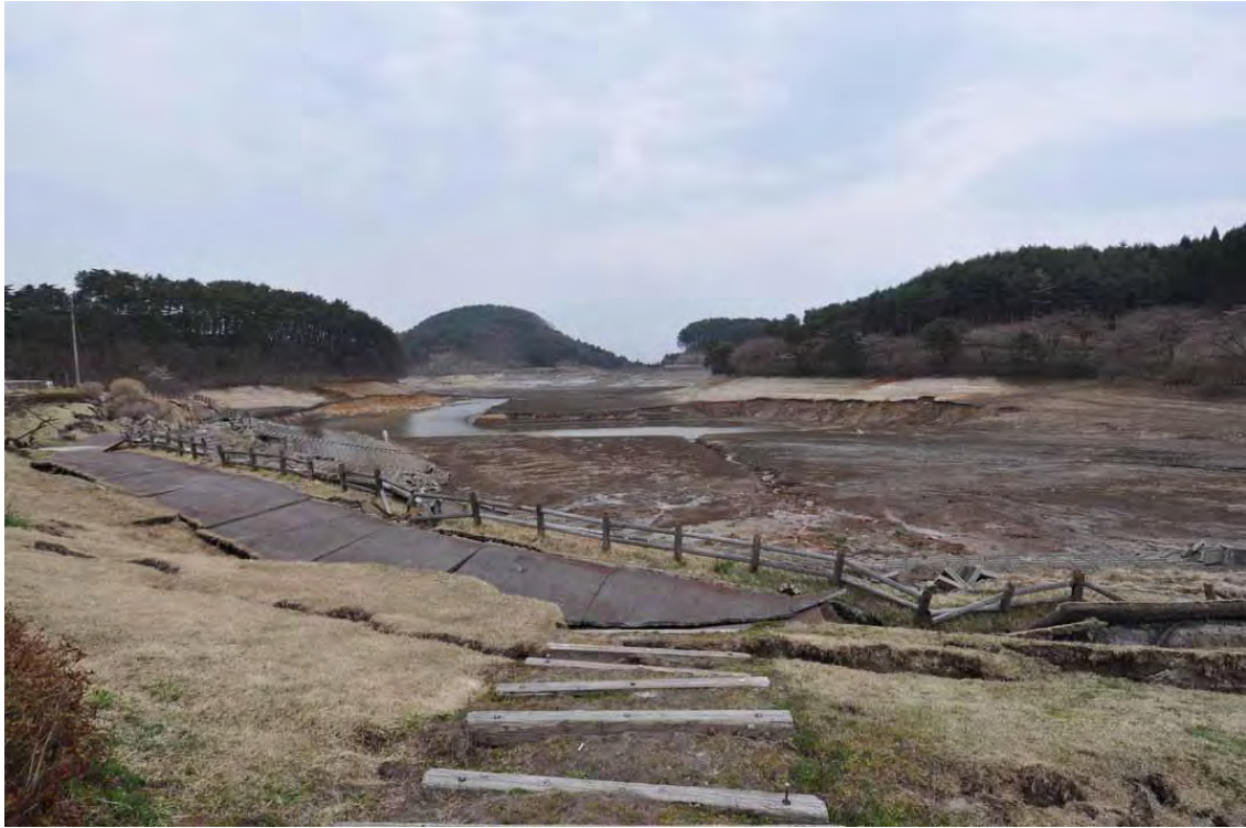
1 水が流出してしまった藤沼貯水池
