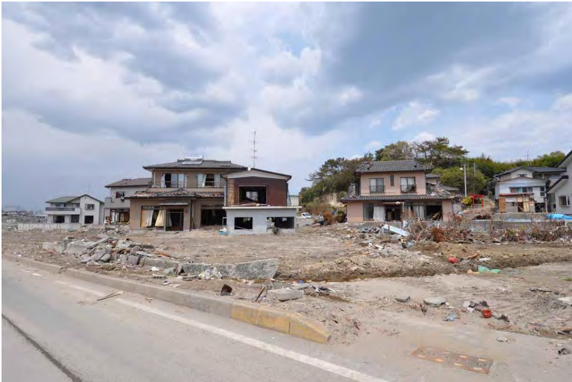
11 少し高台にある家屋は倒壊・流失を免れている
