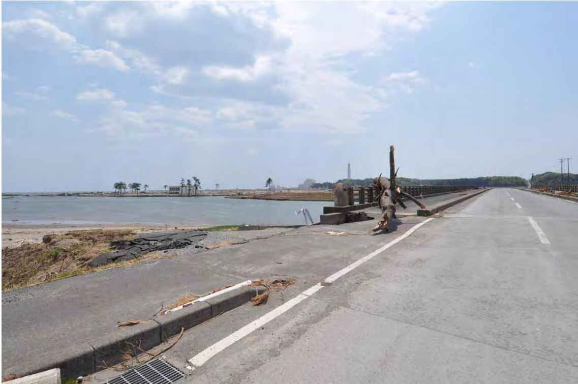
4 真野川河口付近の真島橋の欄干上に打ち上げられた防潮林の流木
