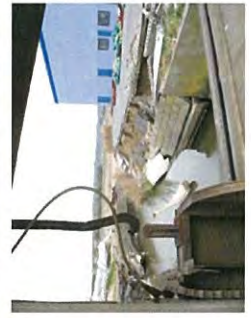
崩壊したコンクリート護岸
