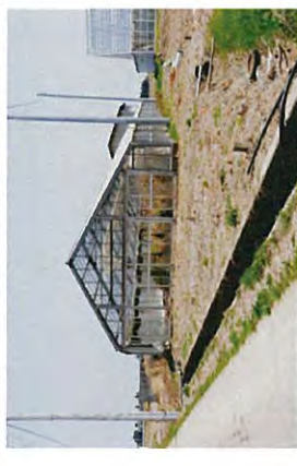
内陸部のガラス温室は、津波が到達していたが破壊を免れていた。栽培花卉類は枯死していないものもあった
