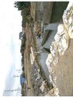
崩壊したコンクリート護岸で大規模土留め緊急措置
