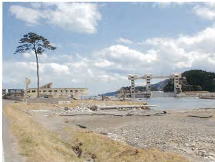
写真—1 陸前高田市 高田の松原(被災状況)
