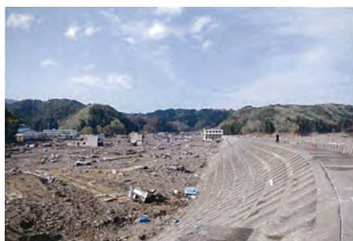
写真 5: 田老市街地 2重の堤防の内側
